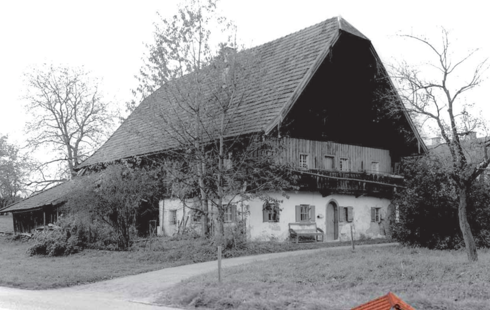
Bauernhaus in Laufen vor und nach der Instandsetzung
